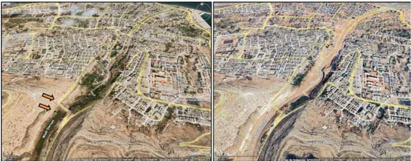
Vista aérea de la Ciudad de Derna. La foto del lado izquierdo es de hace dos años, la de la derecha después de la inundación hace unos días. Las flechas rojas indican la ubicación de la presa y de la obra de desfogue para controlar el desbordamiento.
